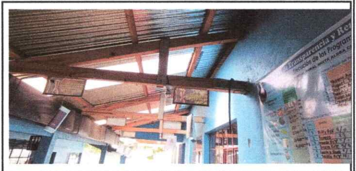
Foto 1: SUSTITUCION DE TECHADO PATIO POR METAL
