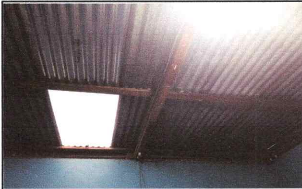
Foto 1: SUSTITUCION DE TECHO MADERA POR METAL TERCER GRADO
