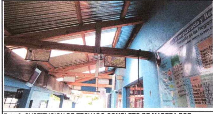
Foto 3: SUSTITUCION DE TECHADO COMPLETO DE MADERA POR METAL.
