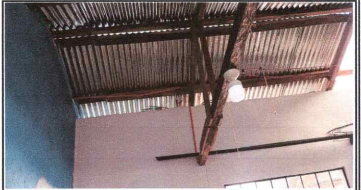
Foto 1: SUSTITUCION DE TECHO MADERA POR METAL, AULA DE 4TO
