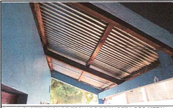
Foto 2: SUSTITUCION DE TECHADO DE MADERA POR METAL
